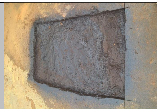
Foto 02: aplicação da massa CBUQ, na Avenida Porto.
