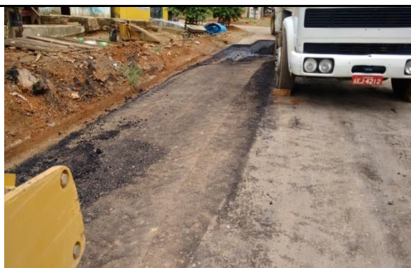
Foto 01: aplicação da massa CBOQ, na Avenida Porto Velho.
