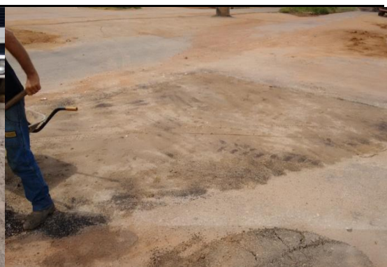
Foto 02: aplicação da massa CBOQ, na Avenida Porto.
