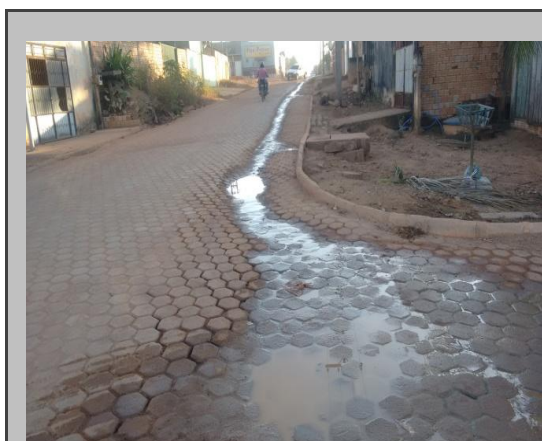
Foto 01: Rua Alta Floresta local antes da recuperação.
