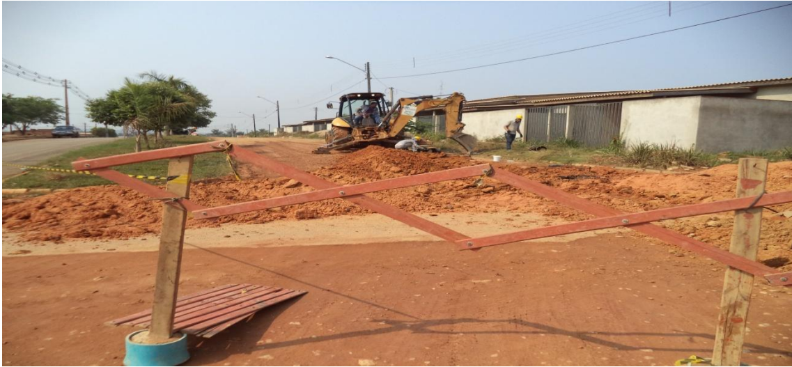
Foto 01: escavação e assentamento de rede 200mm de FoFo e rede de 50mm de PVC – PBA.
