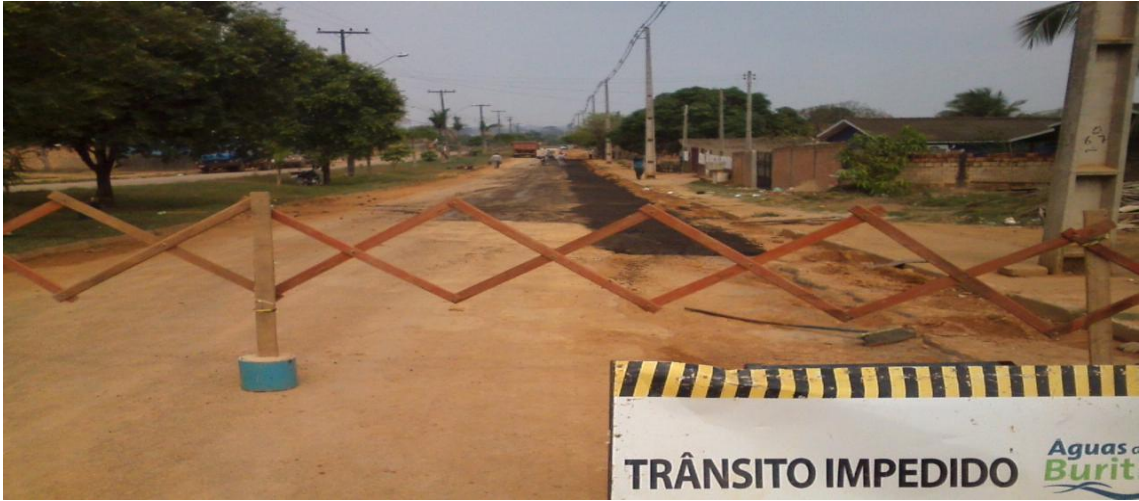
Foto 04: assentamento de massa asfáltica nos locais escavados.
