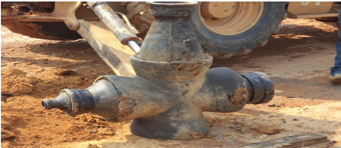
Foto 02: uma cruzeta (1) de 300mm de ferro fundido com RD 200mm, 150mm e de 50mm.
