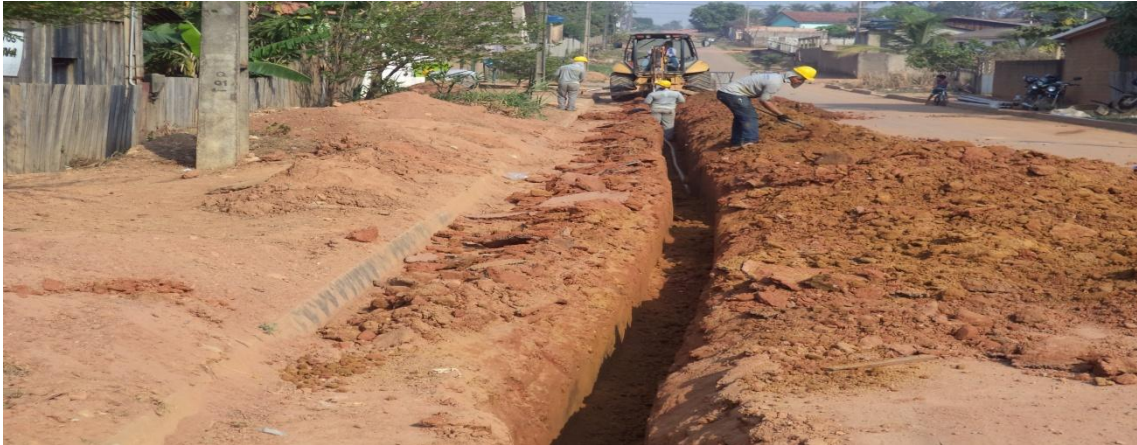
Foto 01: assentamento de rede de distribuição com tubos de 50mm de PVC – PBA.
