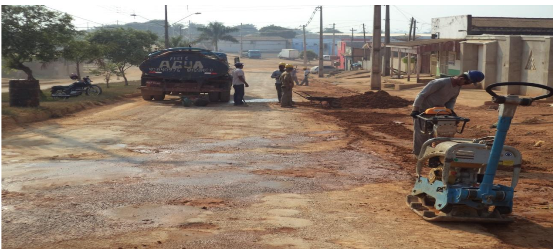
Foto 03: aplicação do material de base para recomposição asfáltica.
