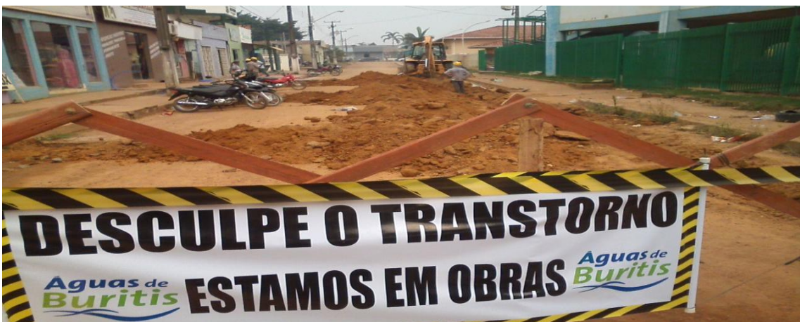
Foto 03: assentamento da rede de distribuição de água com tubos de 50mm de PVC – PBA.
