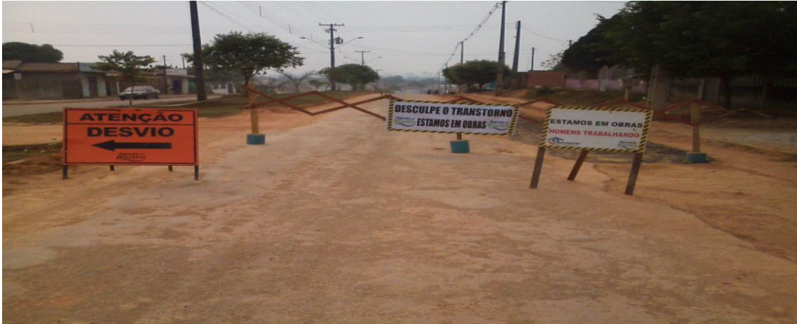
Foto 04: preparação do espaço escavado para reposição asfáltica.
