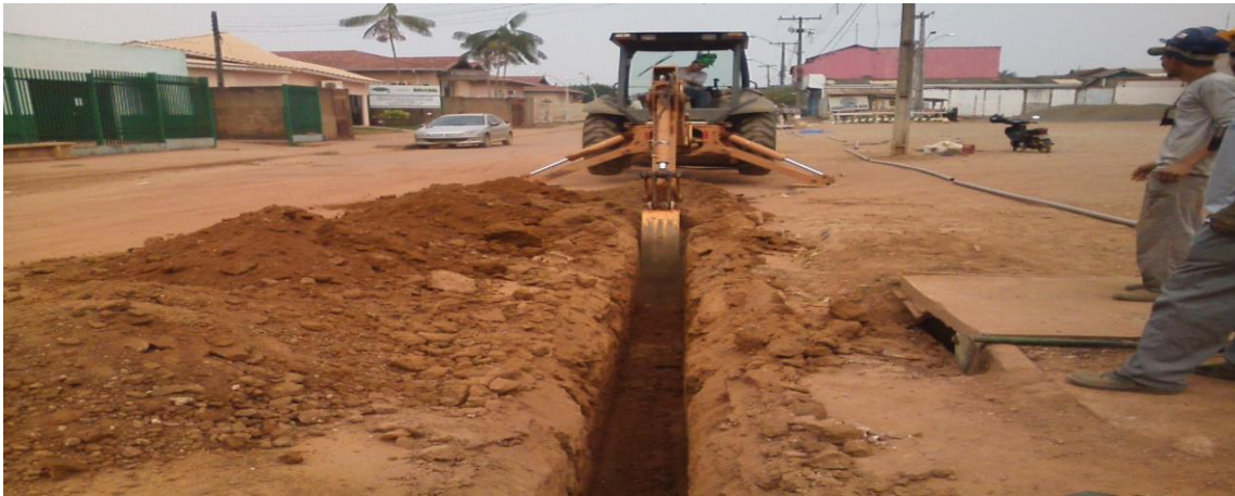
Foto 02: assentamento da rede de distribuição de água com tubos de 50mm de PVC – PBA.
