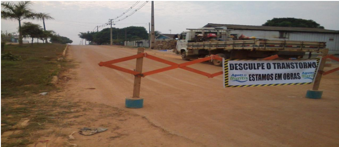
Foto 01: assentamento da rede de distribuição de água com tubos de 50mm de PVC- PBA.
