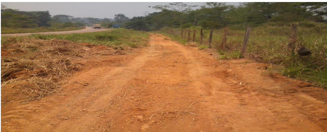
Foto 05: locação da estrada até a área de captação.
