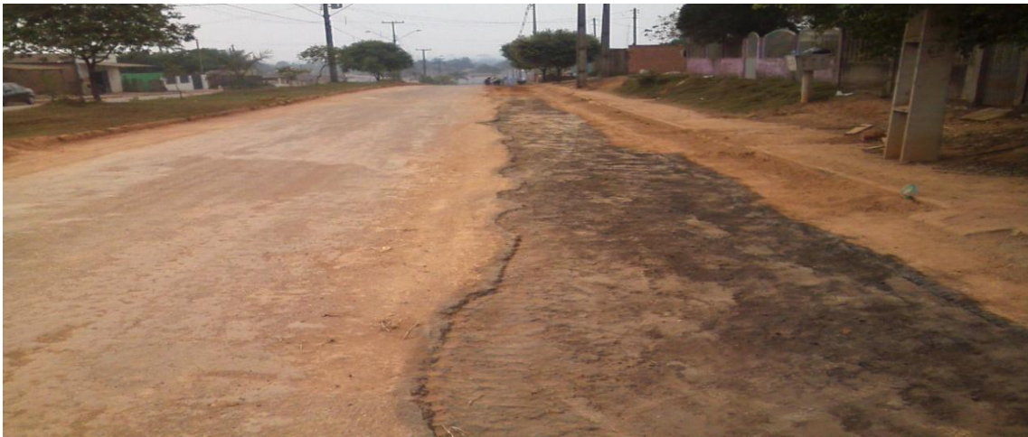
Foto 05: aplicação de ICM – 30 para assentamento da massa asfáltica.
