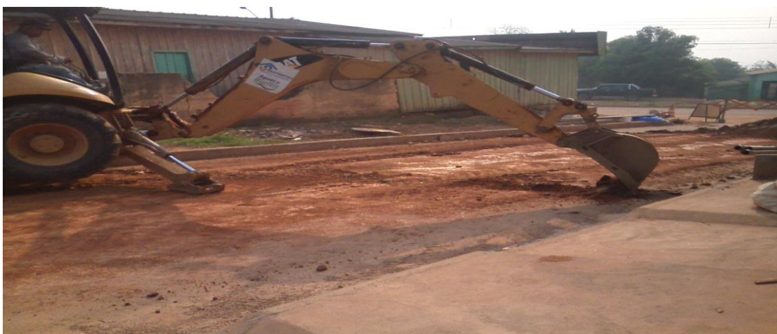
Foto 02: assentamento de rede de distribuição de água.
