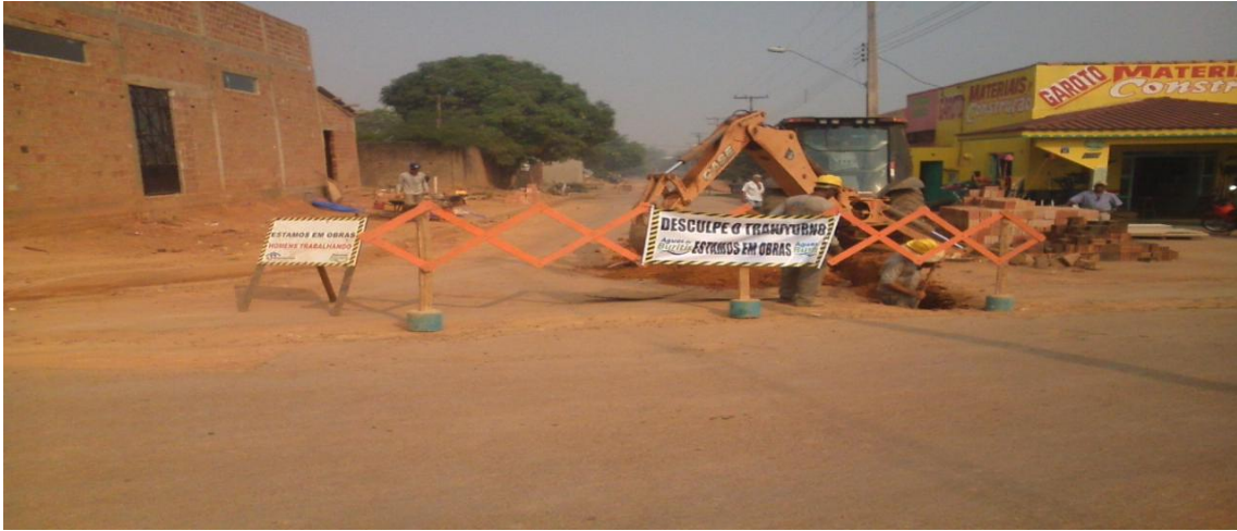
Foto 04: assentamento de rede de distribuição de água com tubos de 50mm de PVC –PBA.
