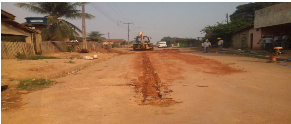
Foto 01: assentamento de rede de distribuição de água.
