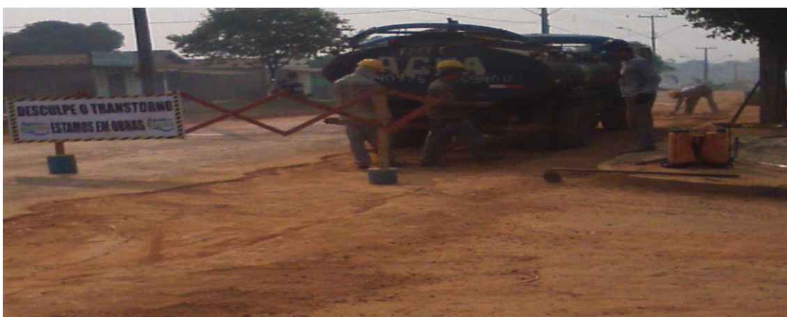
Foto 03: preparação do local escavado para o assentamento asfáltico.
