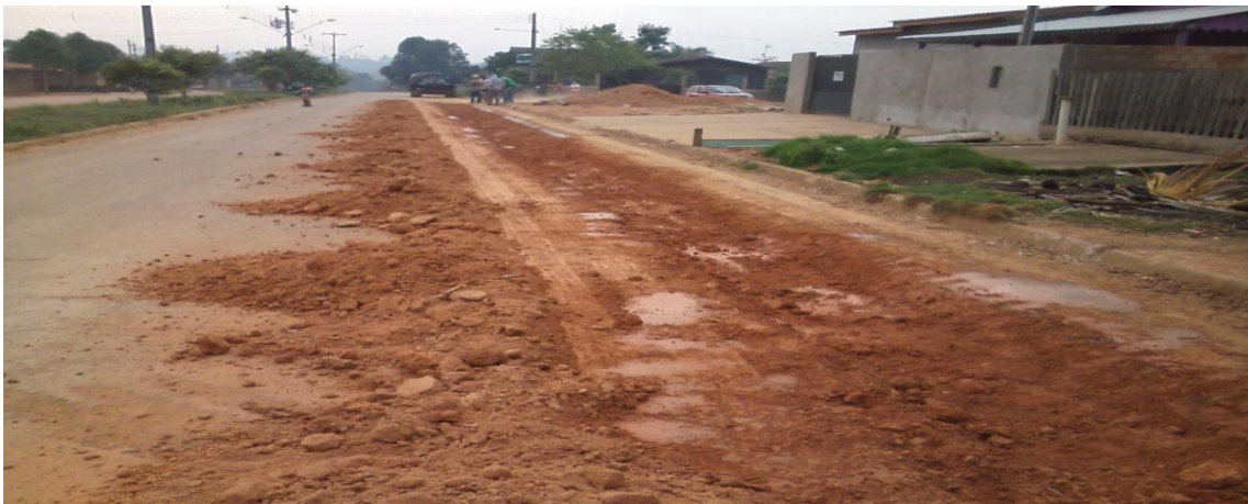
Foto 03: preparação do trecho para reposição asfáltica.
