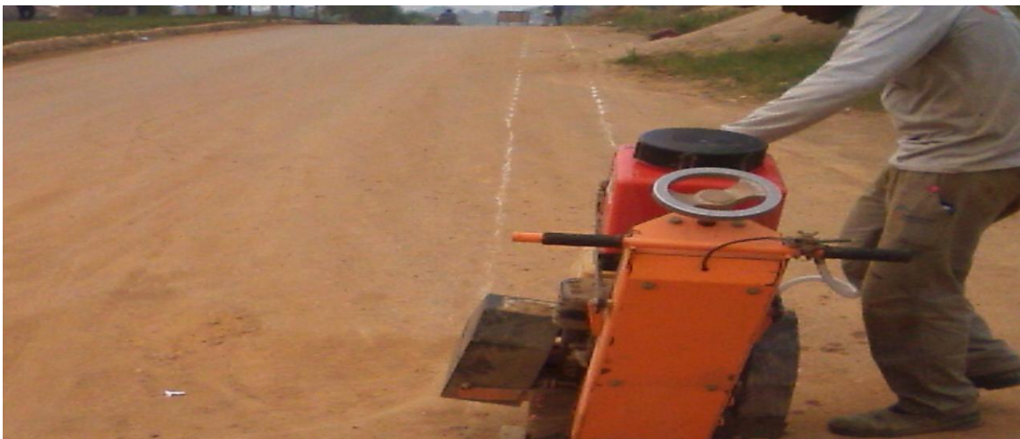
Foto 02: realização do corte no asfalto.
