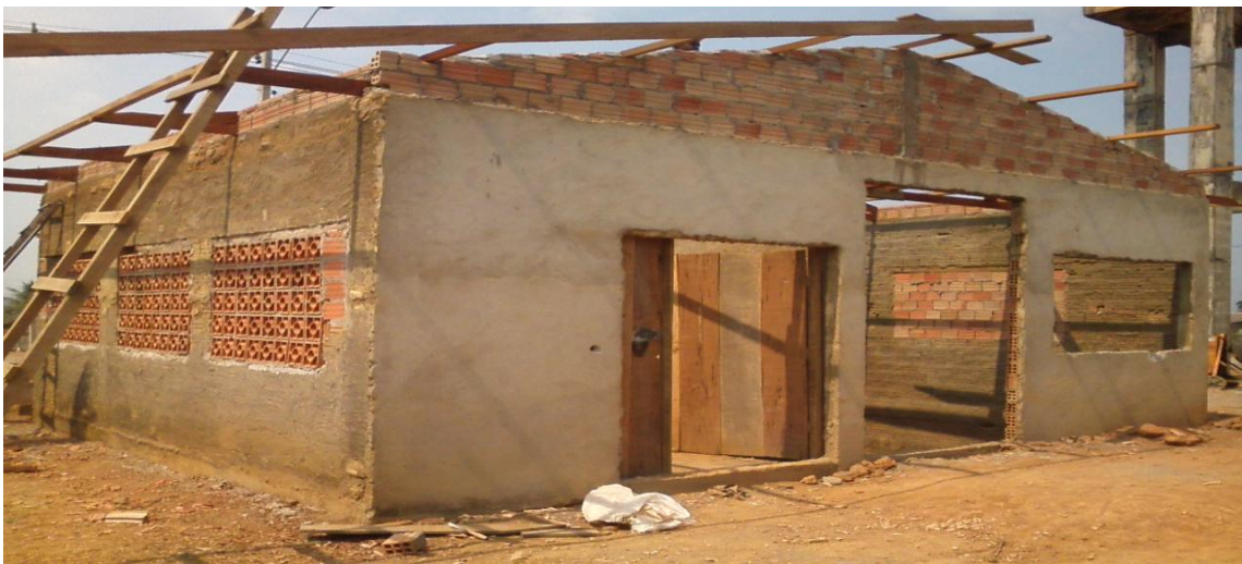
Foto 05: recuperação da casa de química.
