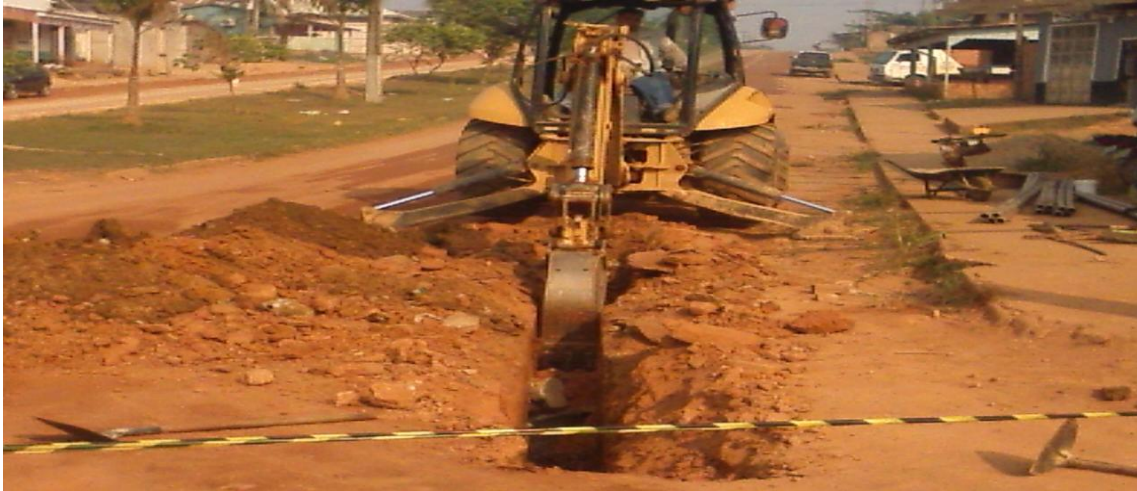
Foto 01: assentamento de rede de distribuição de água com tubos de 50mm de PVC – PBA.
