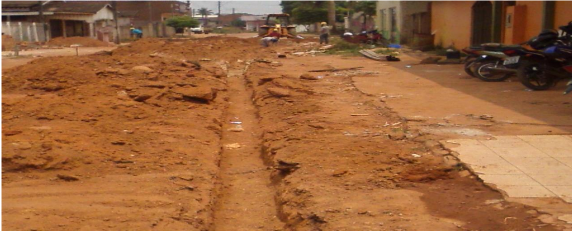
Foto 04: assentamento de rede de distribuição de água com tubos de 50mm de PVC –PBA.
