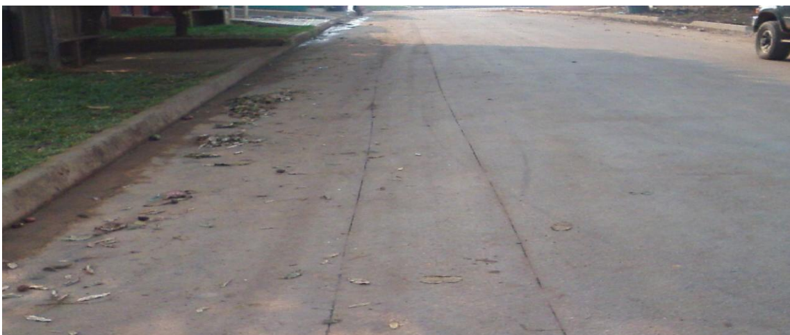
Foto 03: corte no asfalto para escavação.
