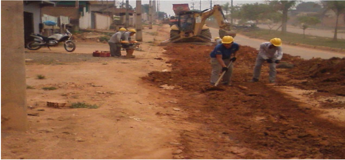
Foto 01: preparação para reposição asfáltica.
