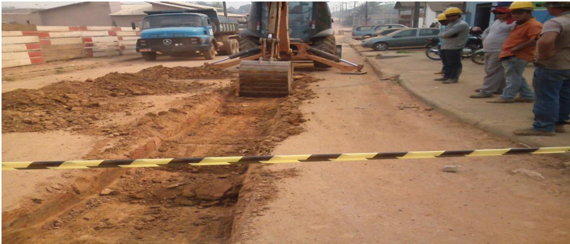
Foto 02: preparação dos trechos escavados para reposição asfáltica.
