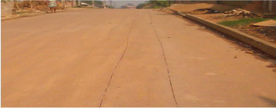
Foto 04: corte no asfalto para escavação.
