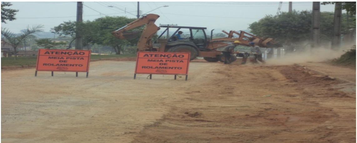
Foto 02: compactação com o material de base para recomposição asfáltica.
