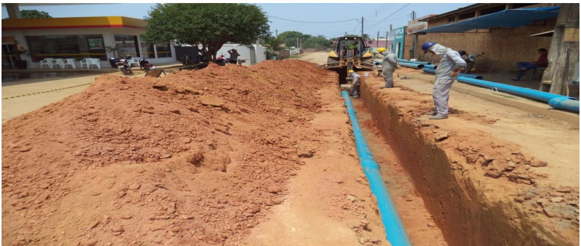
Foto 03: assentamento de rede de distribuição de 200mm de FoFo e 300mm de FoFo.
