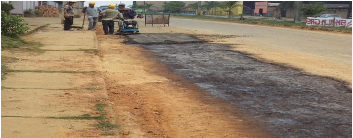
Foto 01: aplicação de ICM – 30 e massa asfáltica na recomposição.
