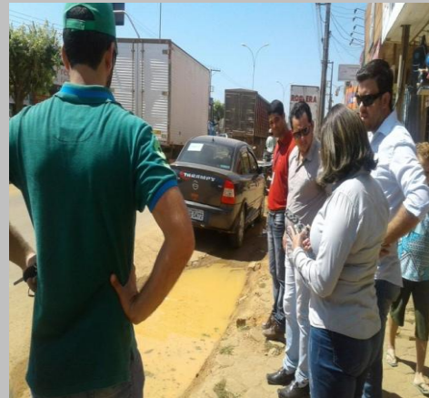
FOTO 08: afundamento do asfalto com rachaduras.
