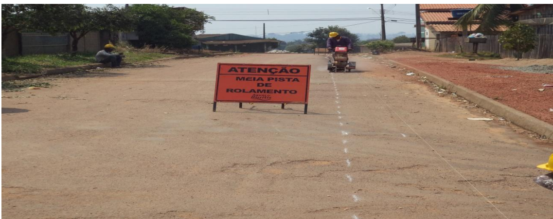
Foto 03: realização do corte no asfalto para assentamento rede.
