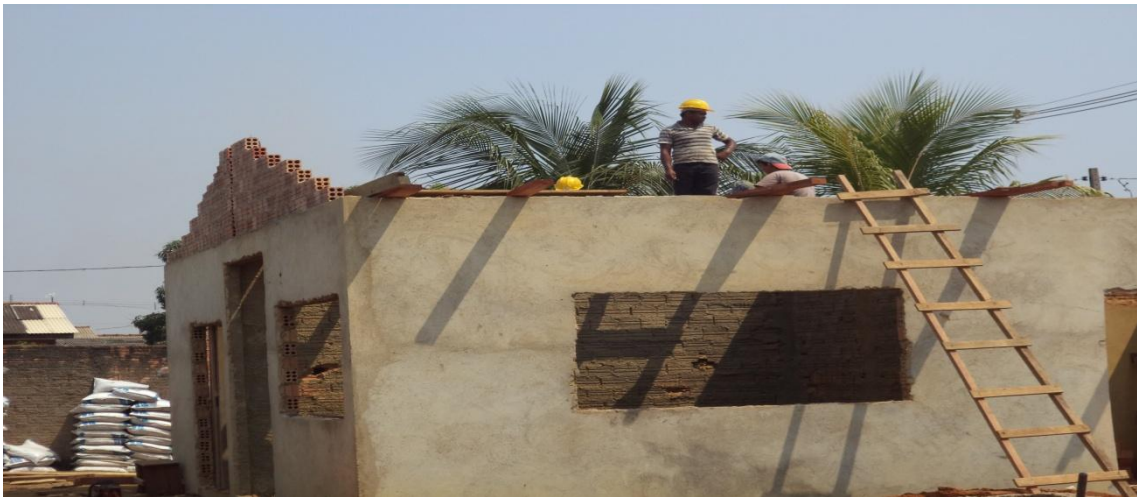
Foto 05: construção e recuperação da casa de química.
