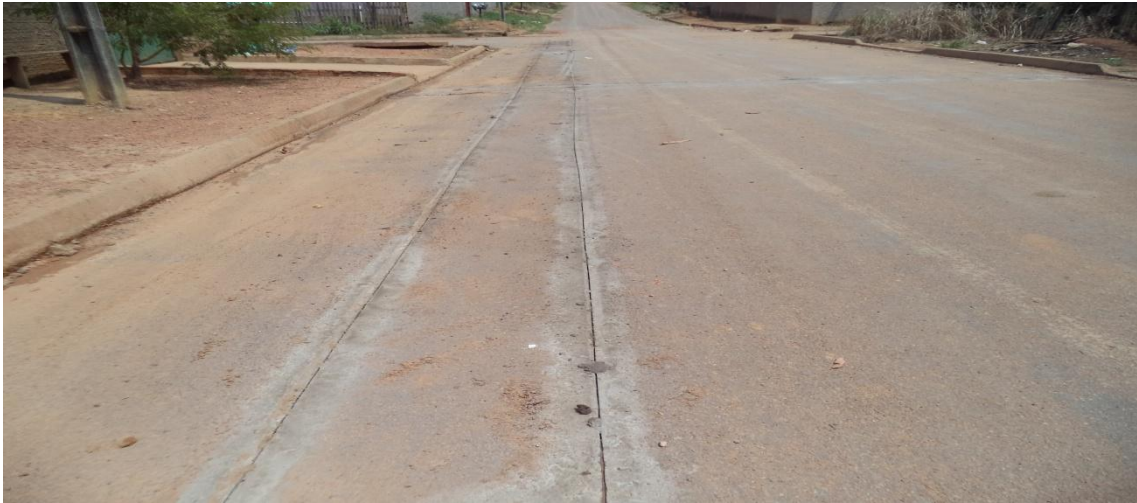
Foto 04: corte no asfalto para realização de assentamento de rede.
