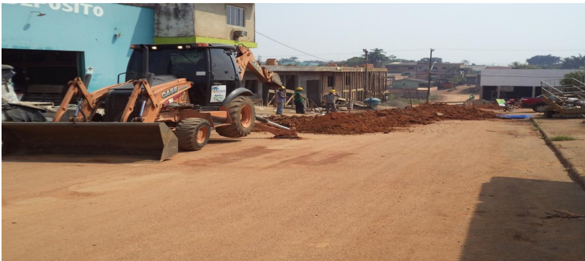
Foto 02: assentamento de rede de distribuição de 50mm de PVC – PBA.
