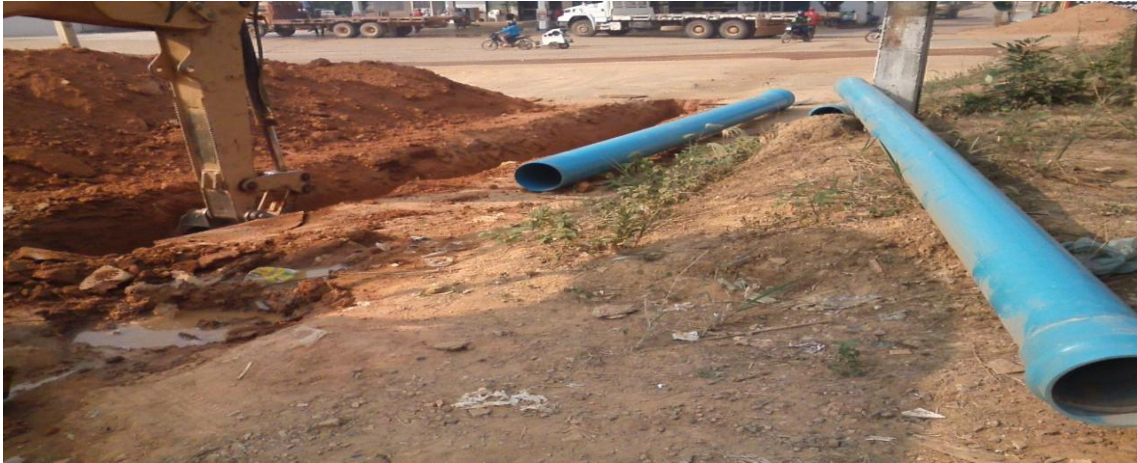
Foto 01: assentamento de tubulações 200mm de FoFo e 300mm FoFo.
