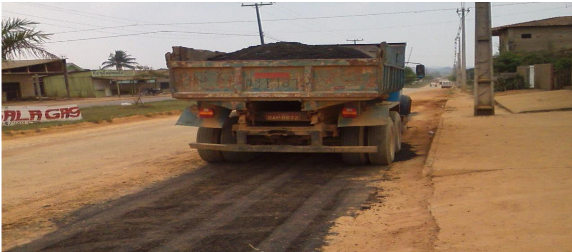
foto 05: aplicação do ICM – 30 e assentamento da massa asfáltica para a recomposição.
