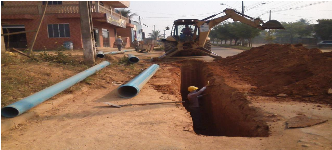
Foto 01: assentamento de tubulações de 300mm e 200mm ambos de FoFo com uma cruzeta de 200mm, um (T) de 300
