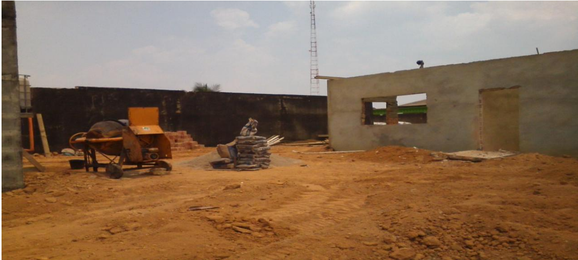
Foto 04: recuperação e adequação da casa de química.
