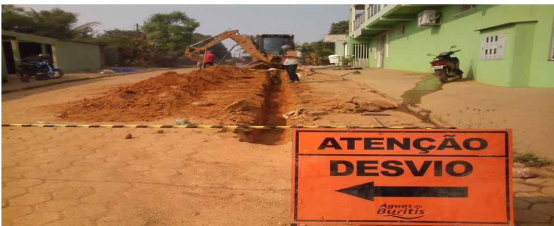
Foto 03: assentamento de rede de distribuição com tubulações de 50mm de PVC – PBA
