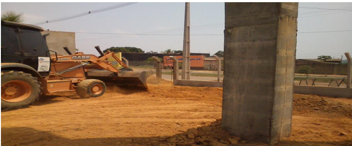
Foto 04: aterramento para nivelção do terreno da estação.
