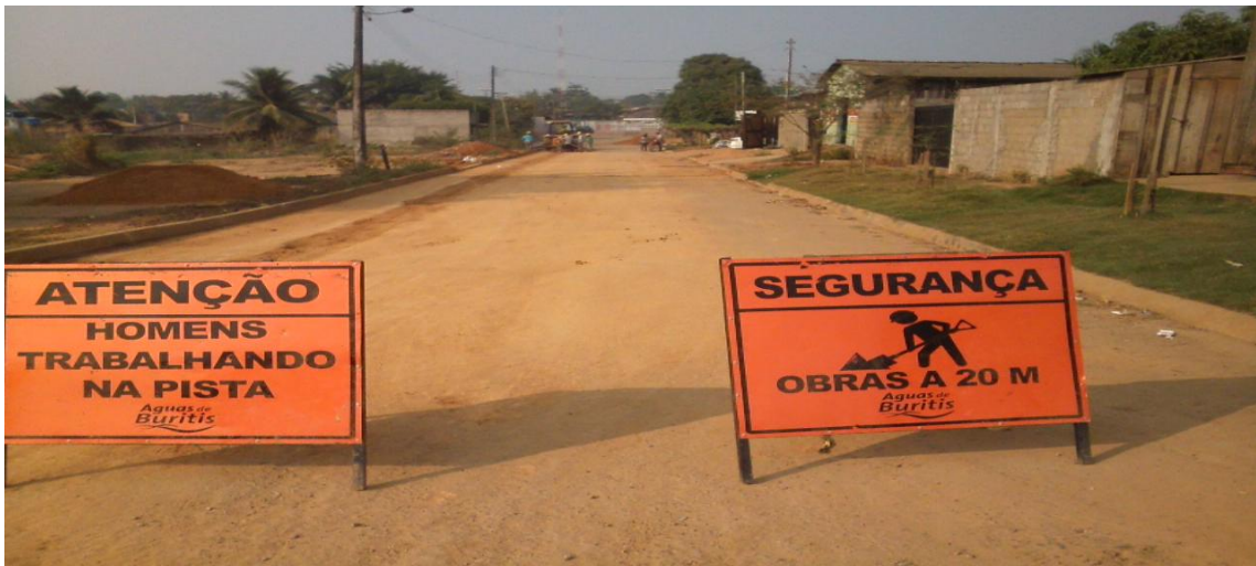
Foto 01: assentamento de rede de 50mm de PVC – PBA, para distribuição de água.
