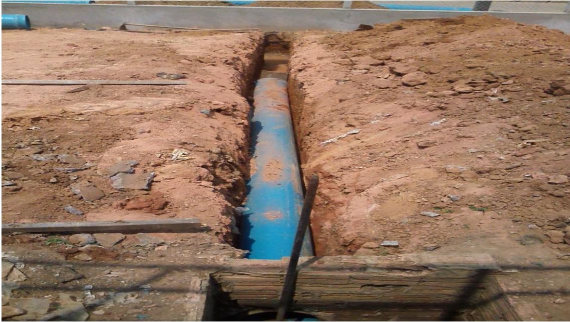
Foto 05: conexão da tubulação de 300mm de FoFo da ETA ate ao sistema de drenagem na rua com duas curvas de 90° de 300mm de ferro fundido.
