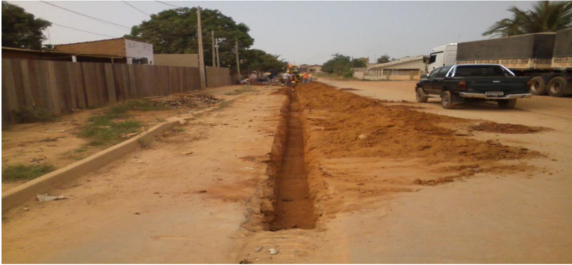
Foto 01: assentamento da rede de 50mm de PVC – PBA para distribuição.
