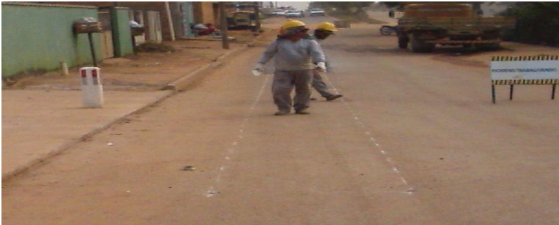
Foto 02 corte no asfalto para assentamento de rede 200mm de FoFo.
