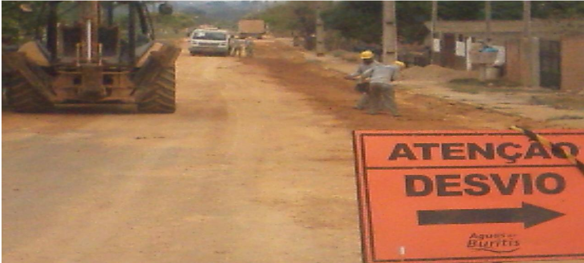
Foto 04: preparação da base com material de cascalho para compactação na recomposição asfáltica.
