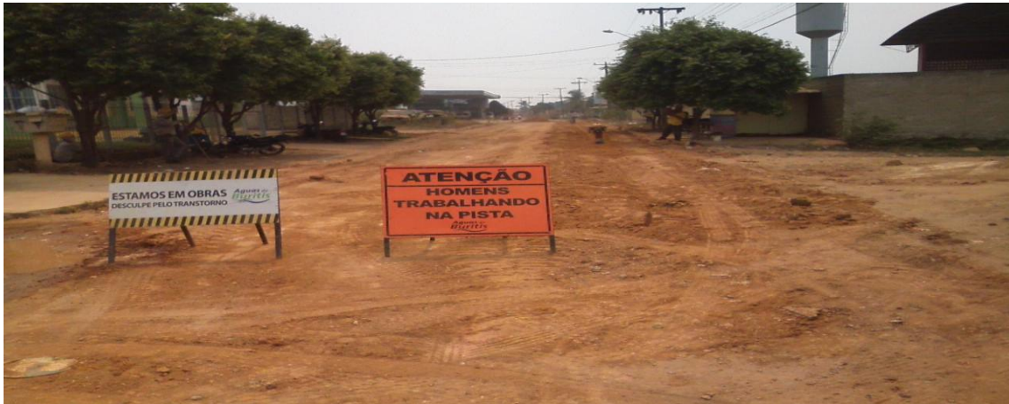
Foto 01: assentamento de rede de 50mm de PVC – PBA para distribuição de água.
