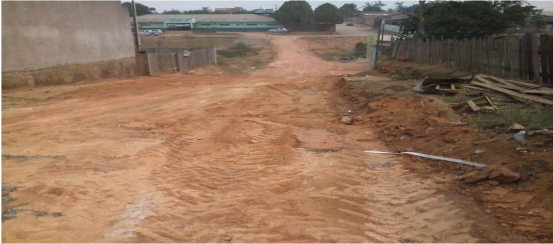
Foto 04: assentamento da rede de 50mm de PVC – PBA para distribuição de água.
