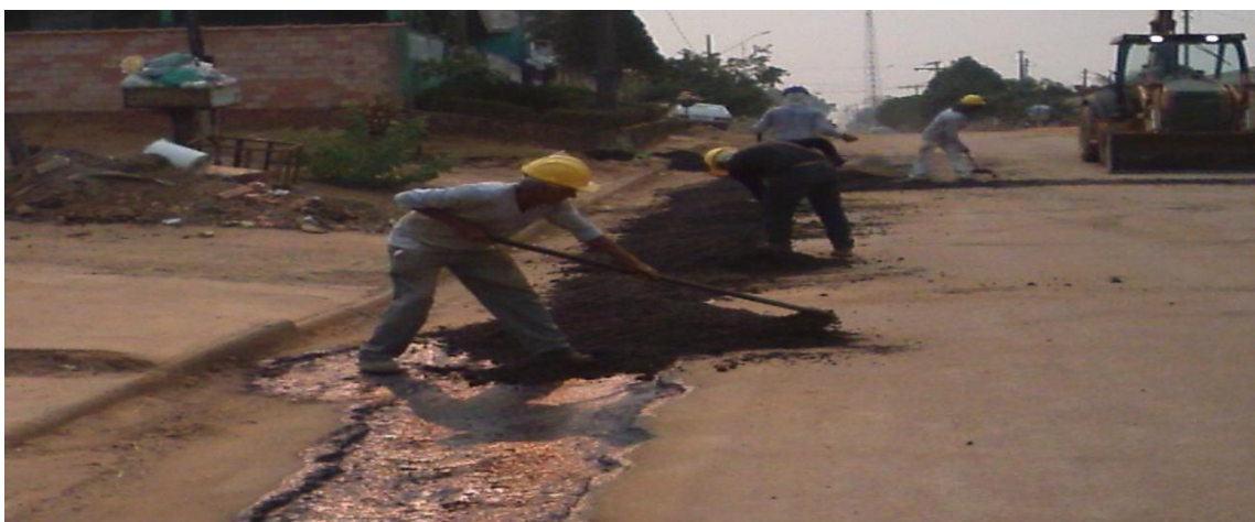
Foto 03: aplicação de ICM – 30, e assentamento asfáltico
