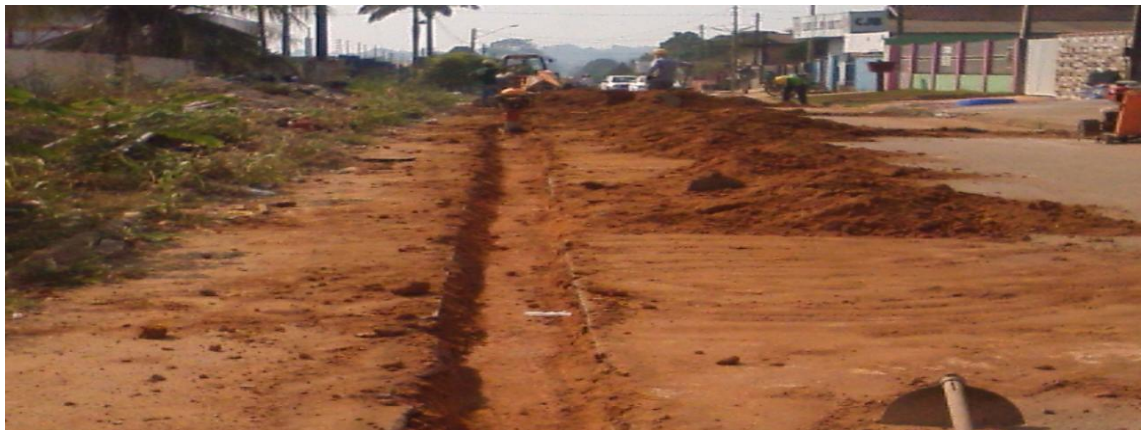
foto 02: assentamento da rede de distribuição de 50mm de PVC – PBA.
