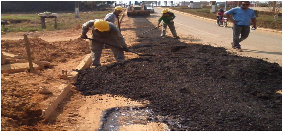
Foto 01: assentamento de massa asfáltica.
