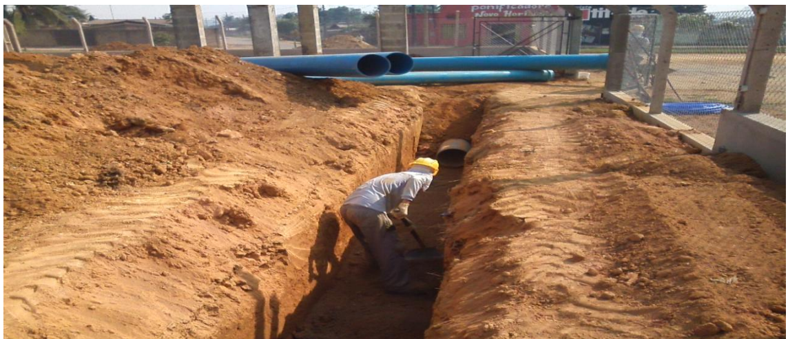
Foto 03: assentamento da adutora 400mm de FoFo de captação de água bruta, e rede de distribuição de 300mm de FoFo.
