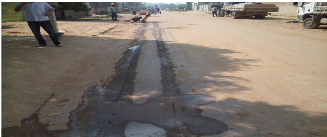
Foto 04: corte no asfalto para escavação das valas e assentamento da rede de 50mm de PVC – PBA.
