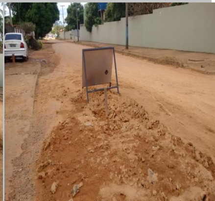
Foto 04: capeamento da rede com a instalação de um registro.
