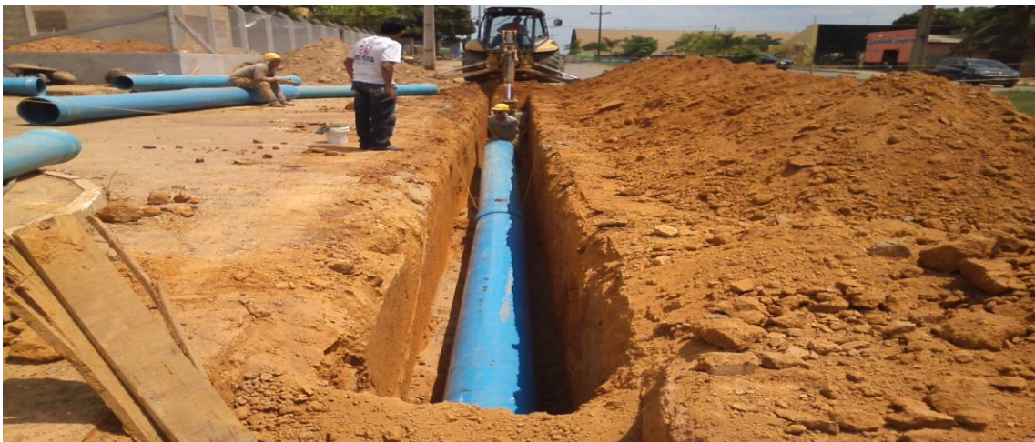
Foto 03: assentamento de adutora de 400mm de FoFo e 300mm de FoFo próximo a ETA.
