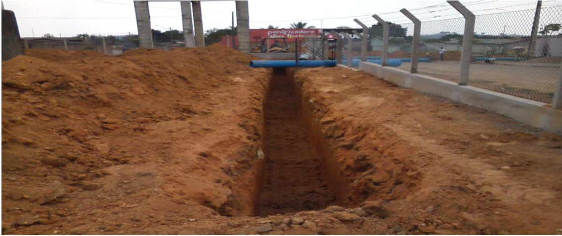
foto 04: escavação dentro da estação para assentamento de adutora de 400mm de FoFo em conexão com a ETA e 300mm de FoFo em conexão a área de reservação.
