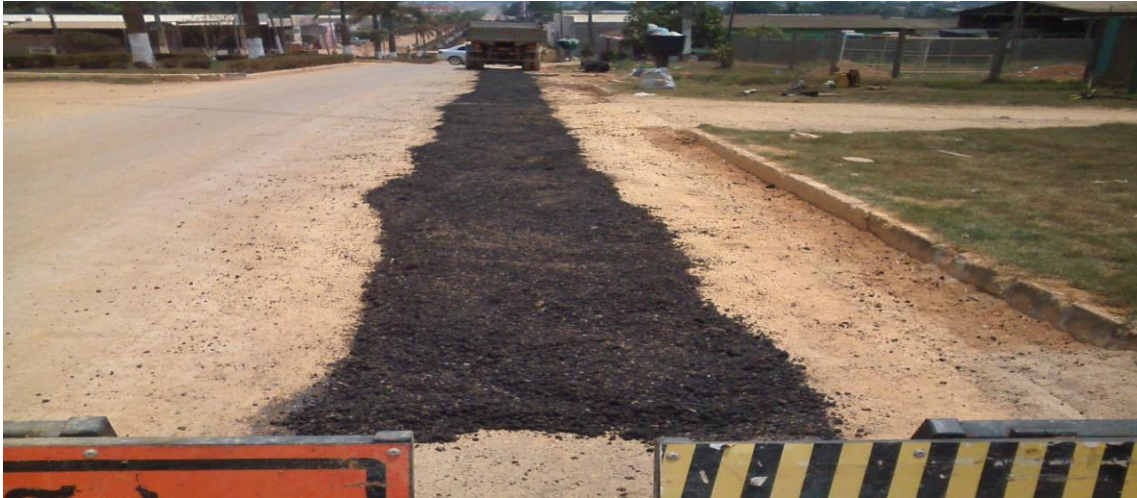
Foto 01: assentamento da massa asfáltica.
