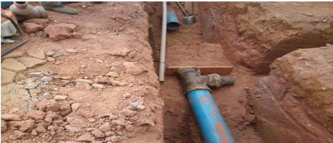
foto 02: conexão da adutora de 200mm de FoFo à rede de distribuição de 100mm de PVC – PBA.
