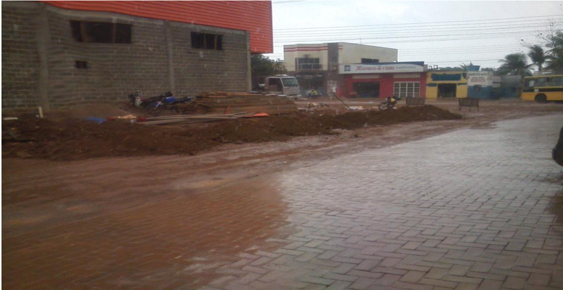
Foto 04: assentamento de rede de distribuição de água de 50mm de PVC – PBA.
