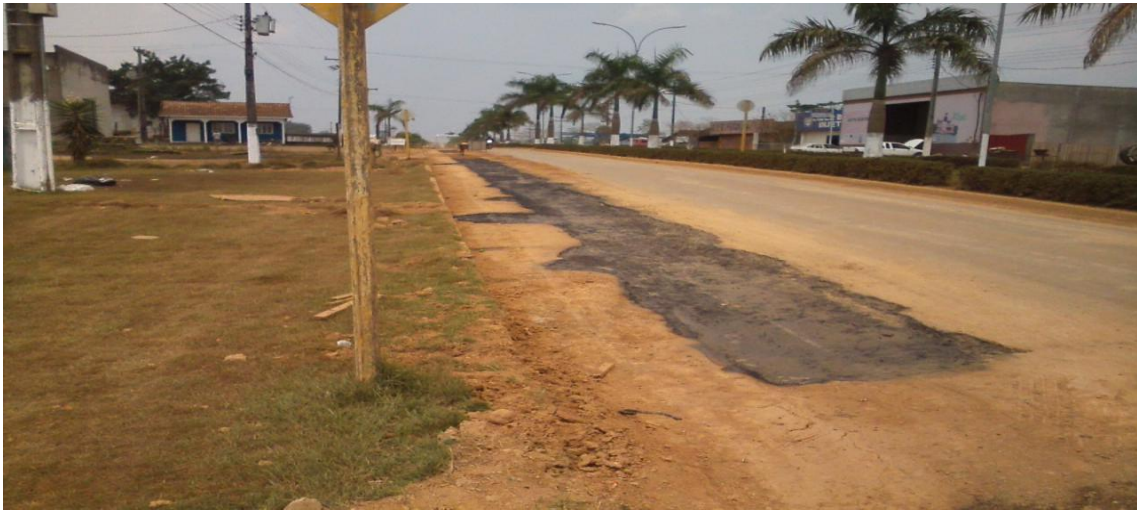
Foto 01: preparação do trecho escavado para recomposição asfáltica.
