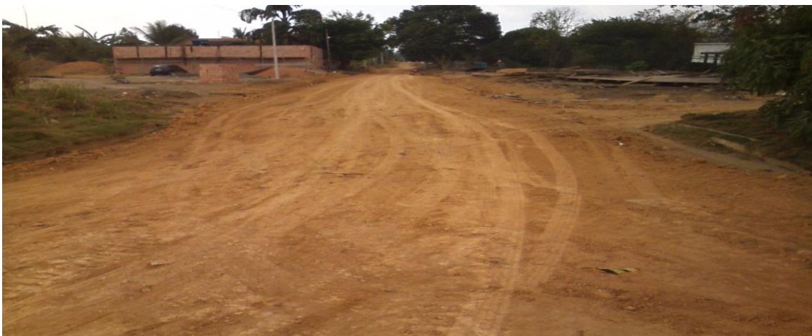
Foto 03: assentamento de rede de distribuição de água de 50mm de PVC – PBA.
