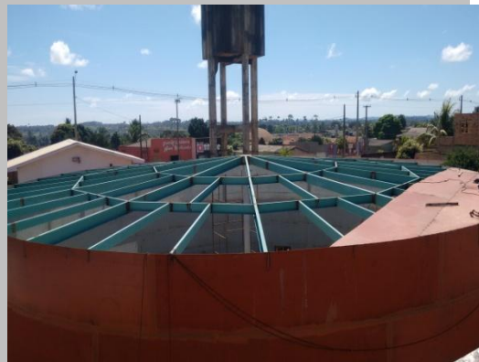
Foto 04: cobertura do reservatório em estrutura metálica.
