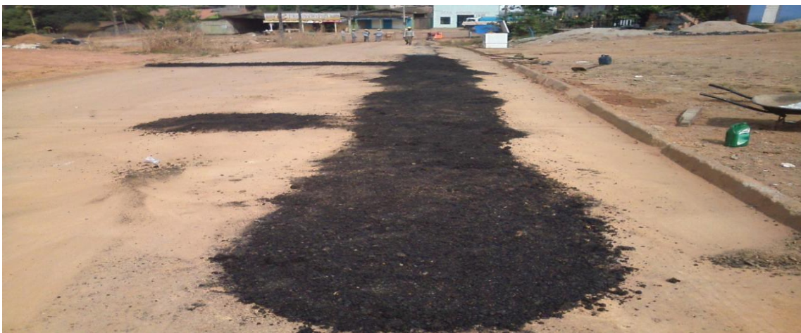
Foto 03: aplicação da massa asfáltica para recomposição.
