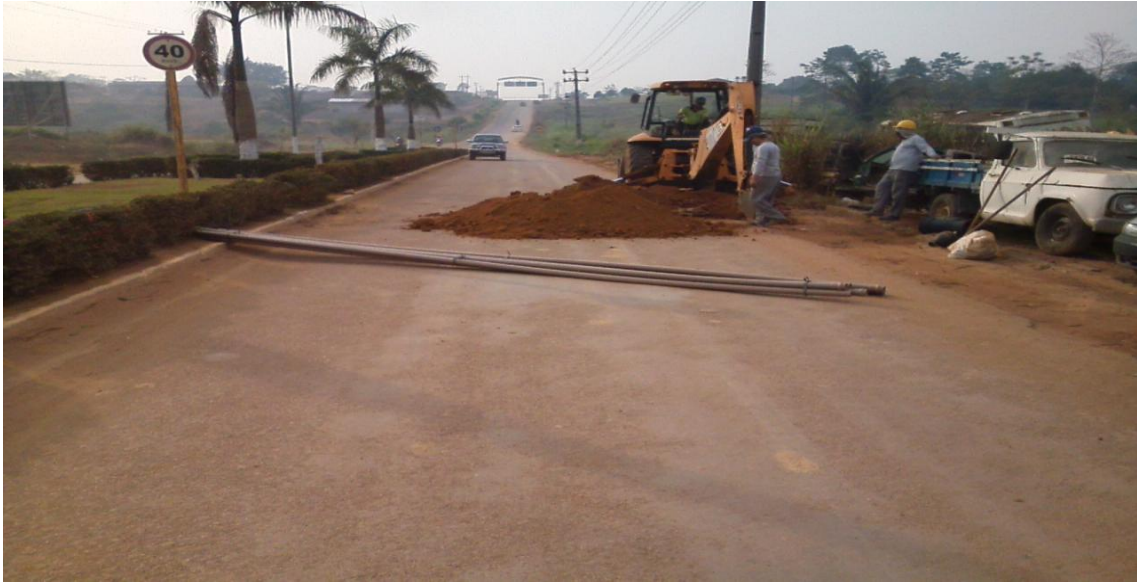
Foto 01: conexão da adutora de 200mm de FoFo com a adutora de 400mm de FoFo.
