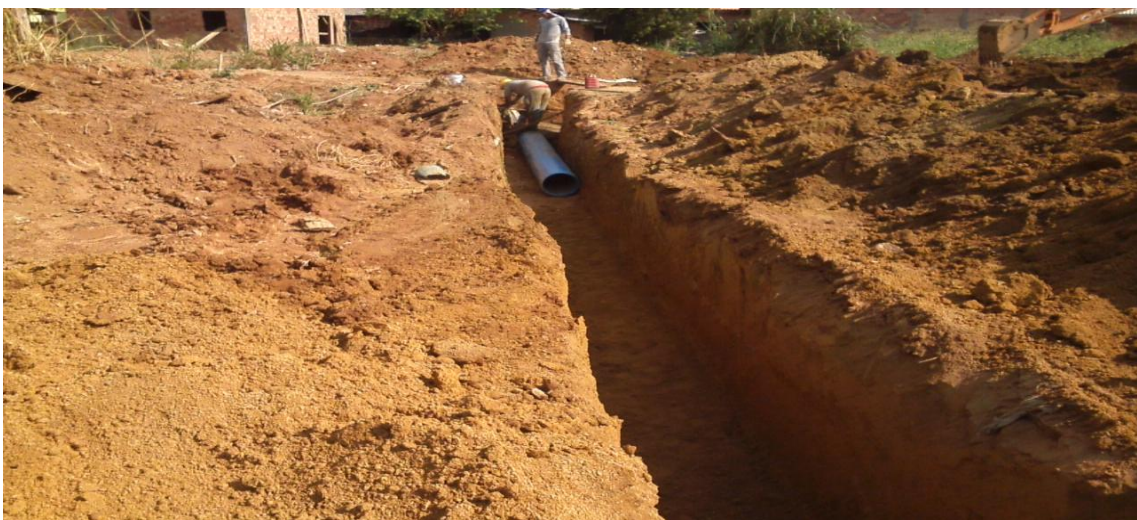
Foto 03: assentamento da adutora de 400mm de FoFo para captação de água bruta.
