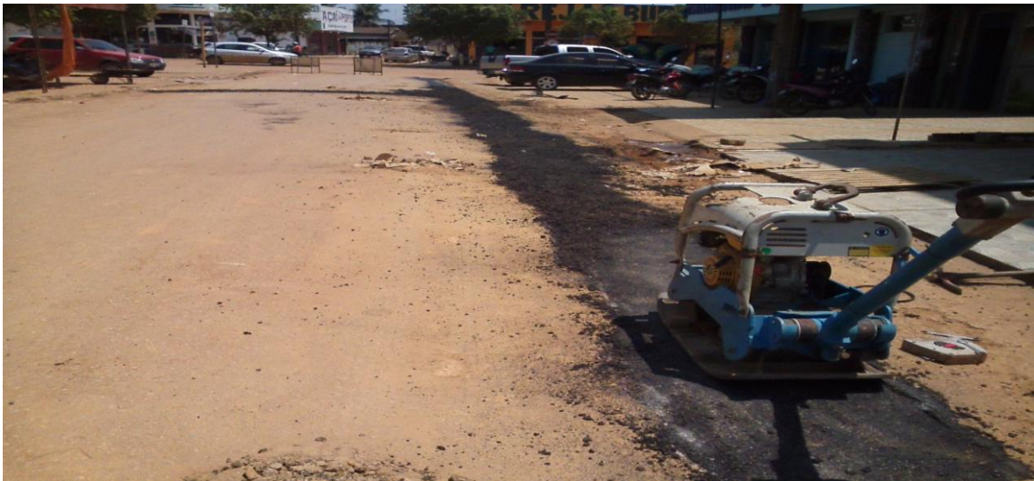
Foto 02: aplicação de massa asfáltica para recomposição.
