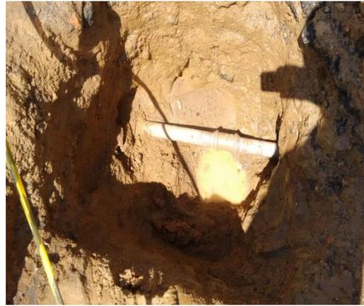
Foto 02: reparos realizados com uma luva de PVC/PBA de 50mm.
