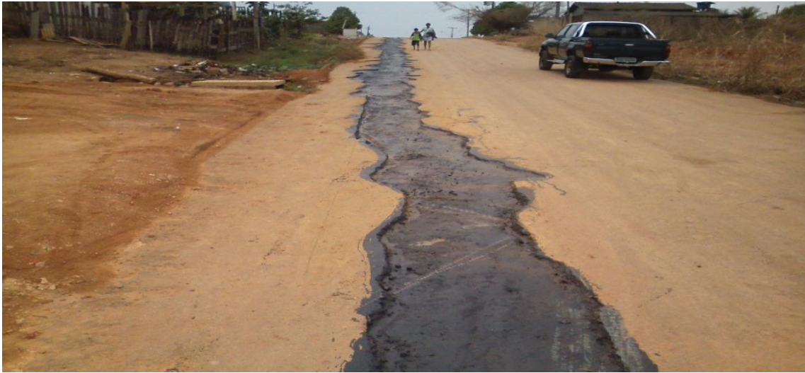
Foto 04: aplicação de ICM – 30 para reposição asfáltica.
