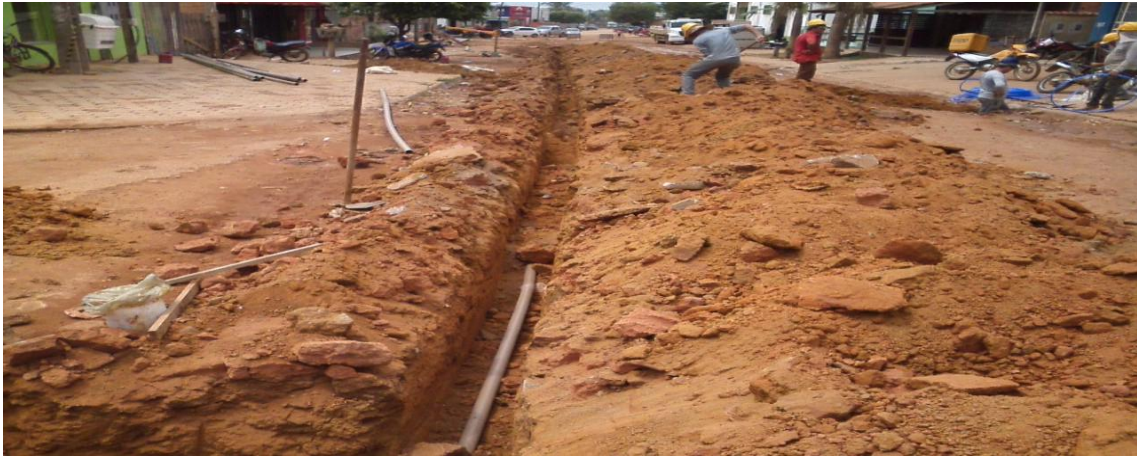
Foto 02: assentamento de rede de distribuição de água de 50mm de PVC, PBA.
