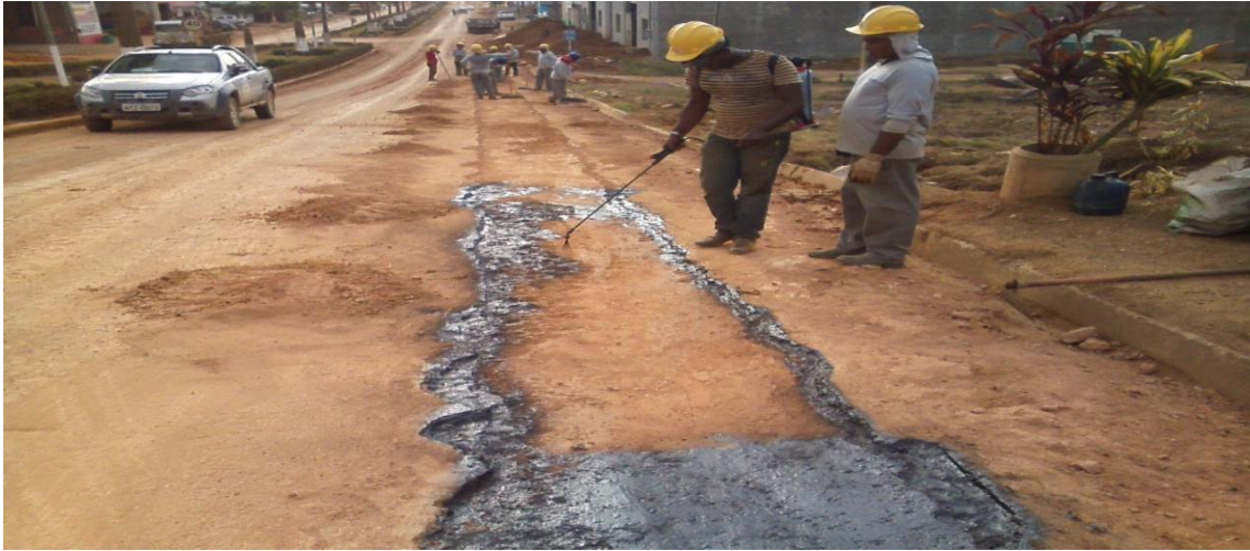
Foto 01: aplicação de ICM – 30 para reposição asfáltica.
