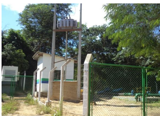
Foto 01: área da captação devidamente cercada e se encontra em operação.
