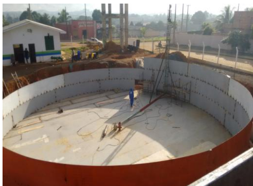
Foto 01: montagem das placas do reservatório.
