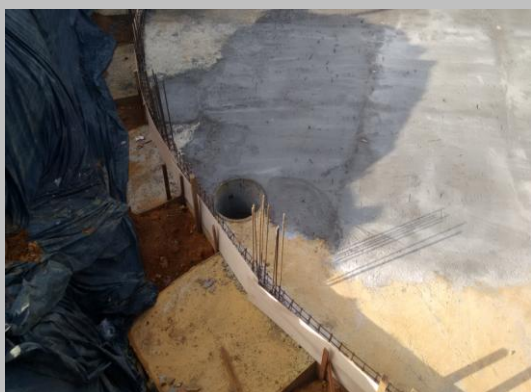
Foto 03: sistema de drenagem de águas fluviais localizado entre a coluna e a estrutura metálica do reservatório.
