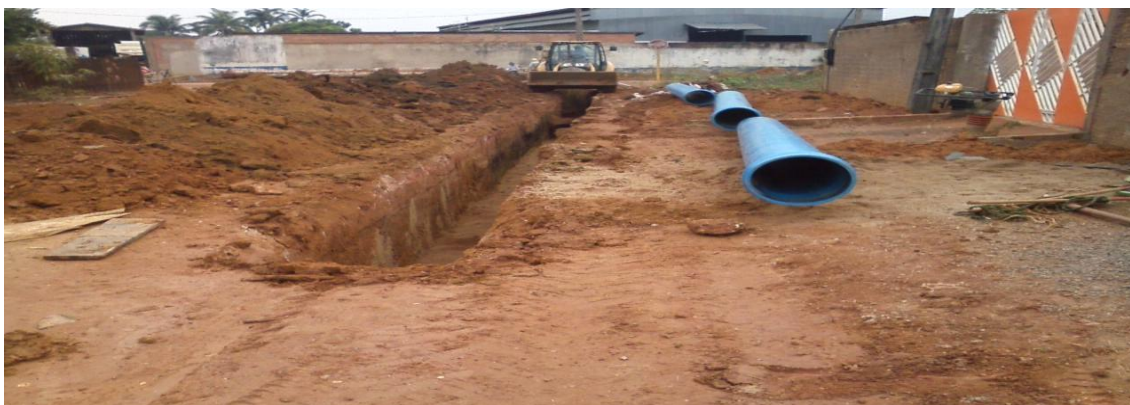
Foto 03: assentamento de adutora de 400mm de FoFo para captação de água bruto.
