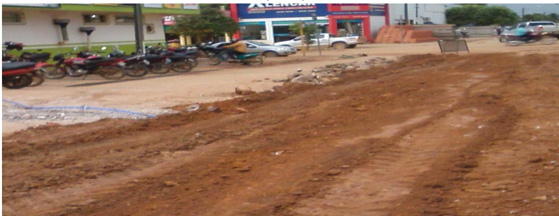
Foto 01: preparação do terreno escavado com material( argila, silte, areia) para compactação
