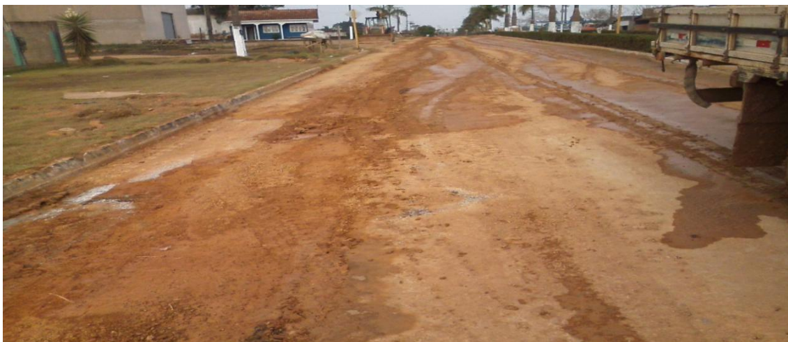
Foto 01: preparação do terreno escavado com material( argila, silte, areia) para compactação
