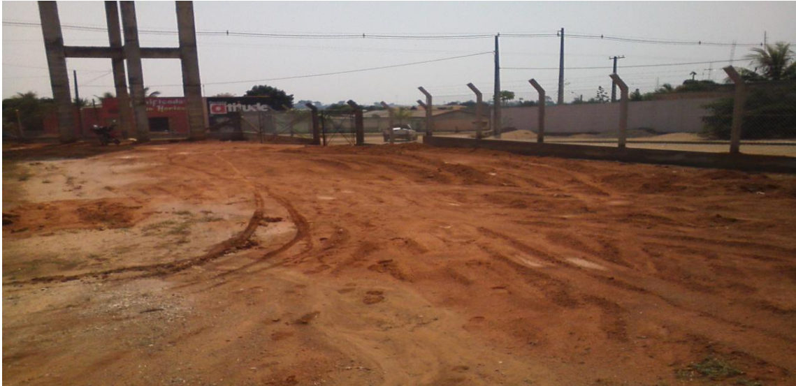
Foto 04: nivelamento do terreno da ETA, com cascalho.
