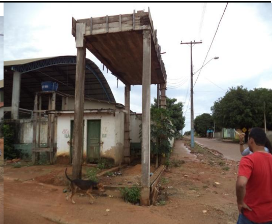
foto 03: possível estrutura da caixa D' água.
