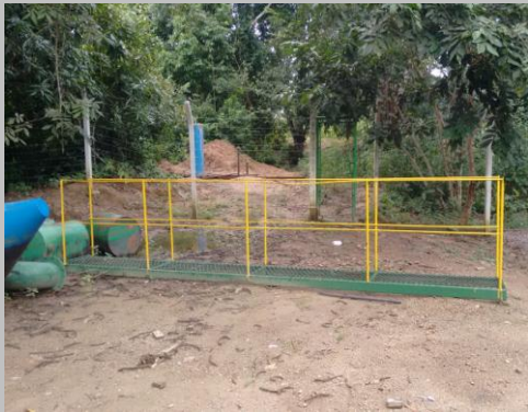
Foto 03: passarela com guarda corpo a ser montada no flutuante.
