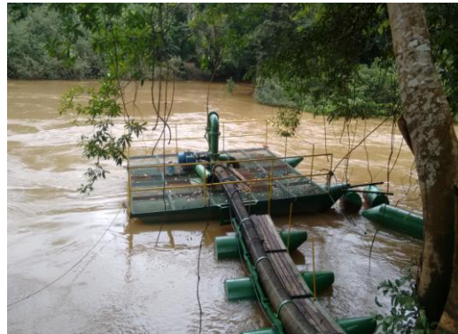
Foto 02: flutuante em operação medindo 5x3,30 equipado com moto bomba e guarda corpo instalado, com passarela a ser montada.
