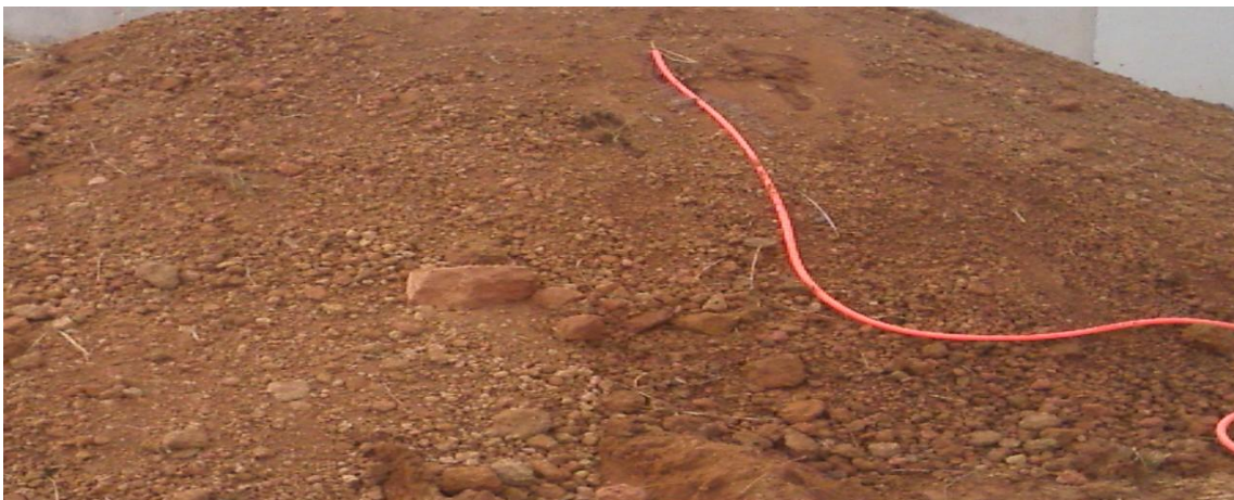
2ª foto: material para compactação (cascalho).
