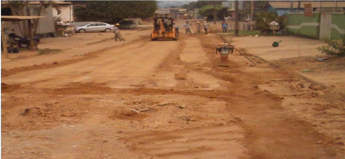
1ª foto: compactação realizada com material( cascalho) com porcentagens de Silti, areia e argila para reposição asfáltica.
