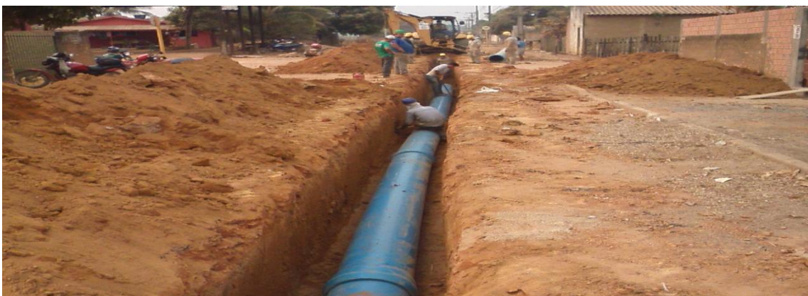
3ª foto: sequencia de assentamento de adutora de 400mm para captação de água bruta.
