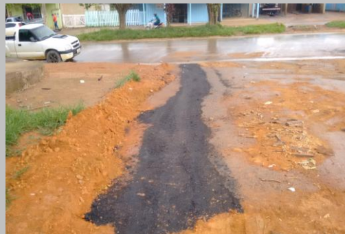
Foto 04: aplicação de CBUQ massa fria na Rua Nova Mamoré.
