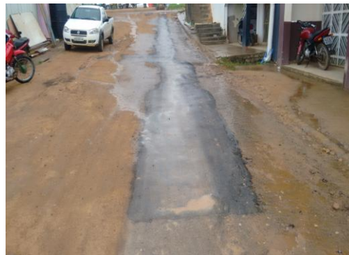
Foto 02: aplicação de CBUQ massa fria na Rua Vitória.
