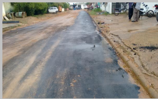
foto 03: aplicação de CBUQ massa fria na Rua travessa 09.
