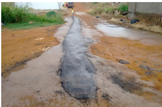
Foto 01: aplicação de CBUQ massa fria na Rua Natal.
