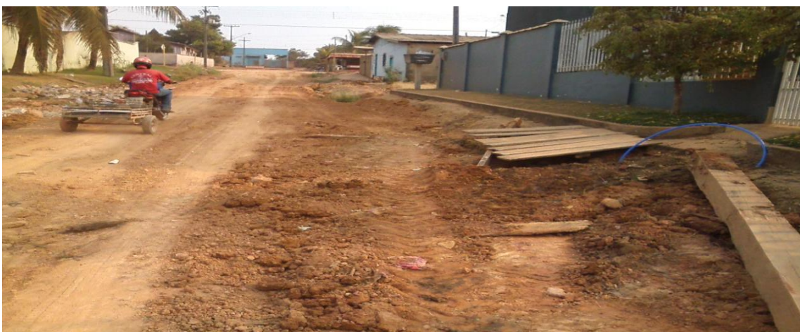
4ª foto: Rua travessa 13 de Maio assentamento de tubos de 50mm.
