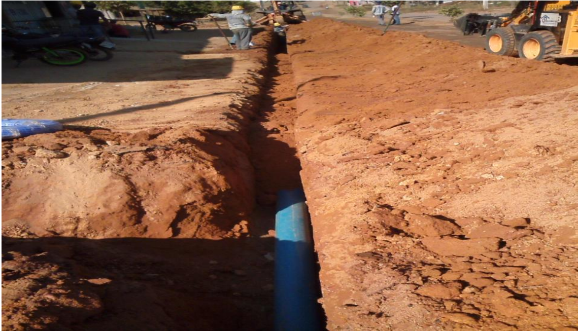
5ª foto: assentamento de tubulação de 150mm de FoFo para rede de distribuição.
