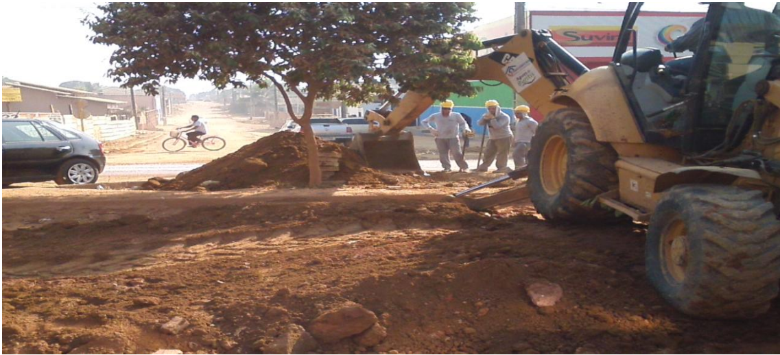
3ª foto: assentamento de uma cruzeta de ferro fundido de 200mm no sentido da rua Alta floresta em conexão com adutora de 400mm de FoFo.
