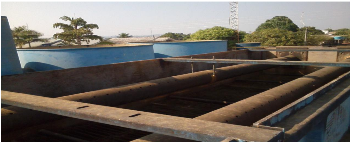
6ª foto: vista interior da Estação.
