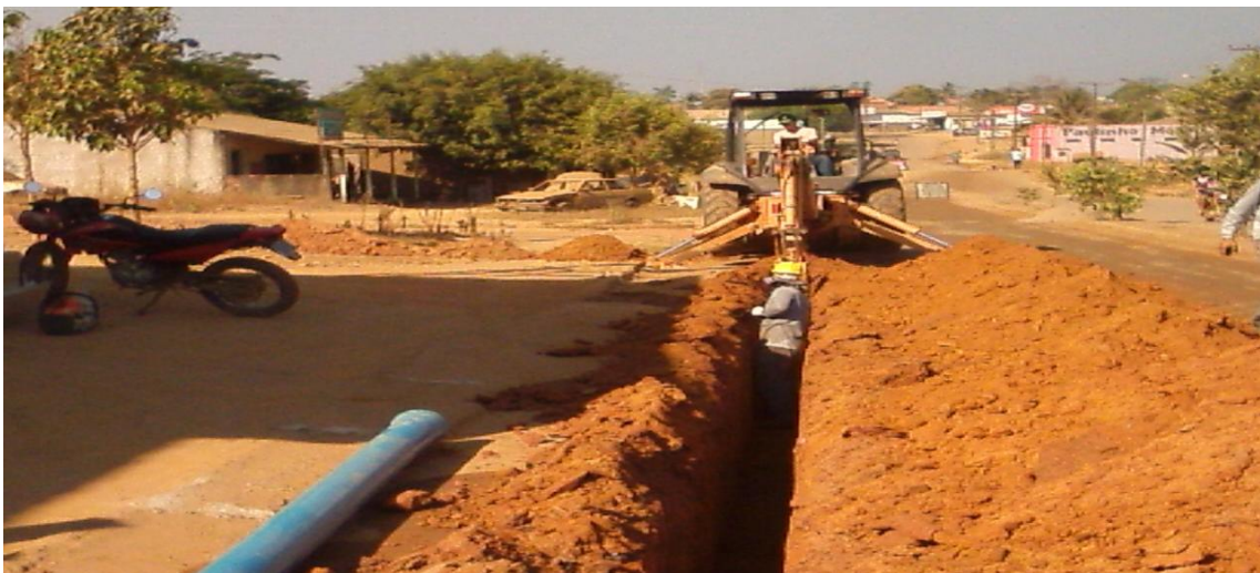
4ª foto: assentamento de tubulações de 150mm para rede de distribuição e tubulações de 50mm de PVC nas entradas das rua sentido setor Nova Porto Velho.
