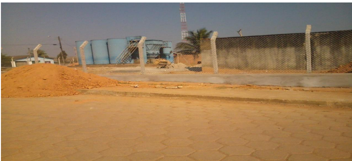
7ª foto: a construção do alambrado da Estação.
