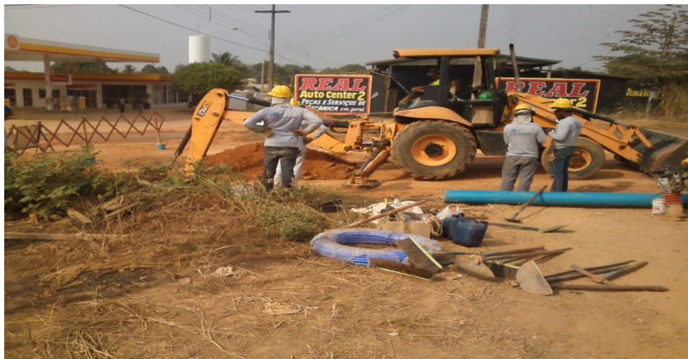
2ª foto: assentamento de tubulação de 200mm de FoFo em rede de distribuição.
