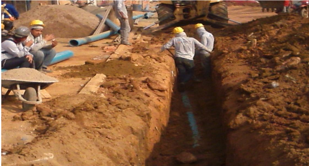
1ª foto: assentamento de tubos de 200mm de FoFo e tubos de 50mm de PVC.
