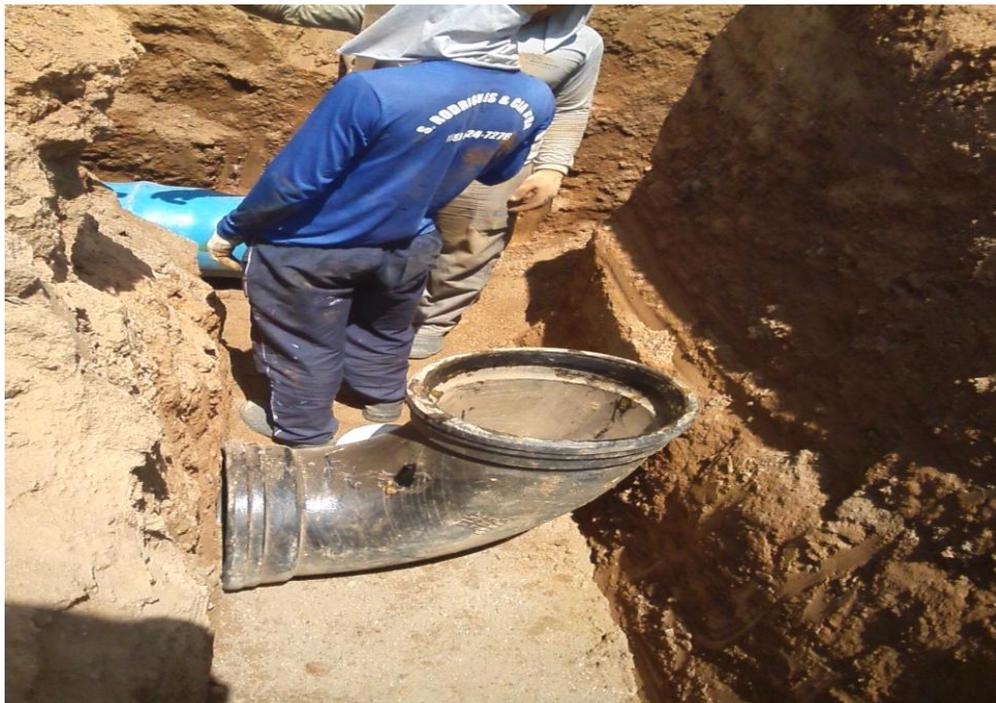
2ª foto: curva de 90º de ferro fundido de 400mm em uma adutora para captação.
