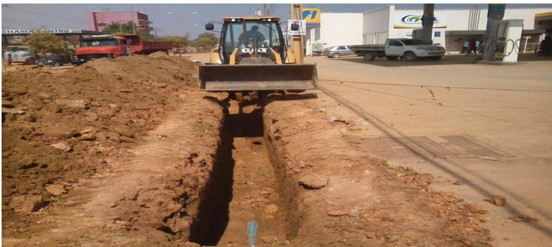
**8ª foto: assentamento de tubulações de 50 e 200mm com uma cruzeta e um (T) de ferro fundido com 3 RD de 200x50mm.**
