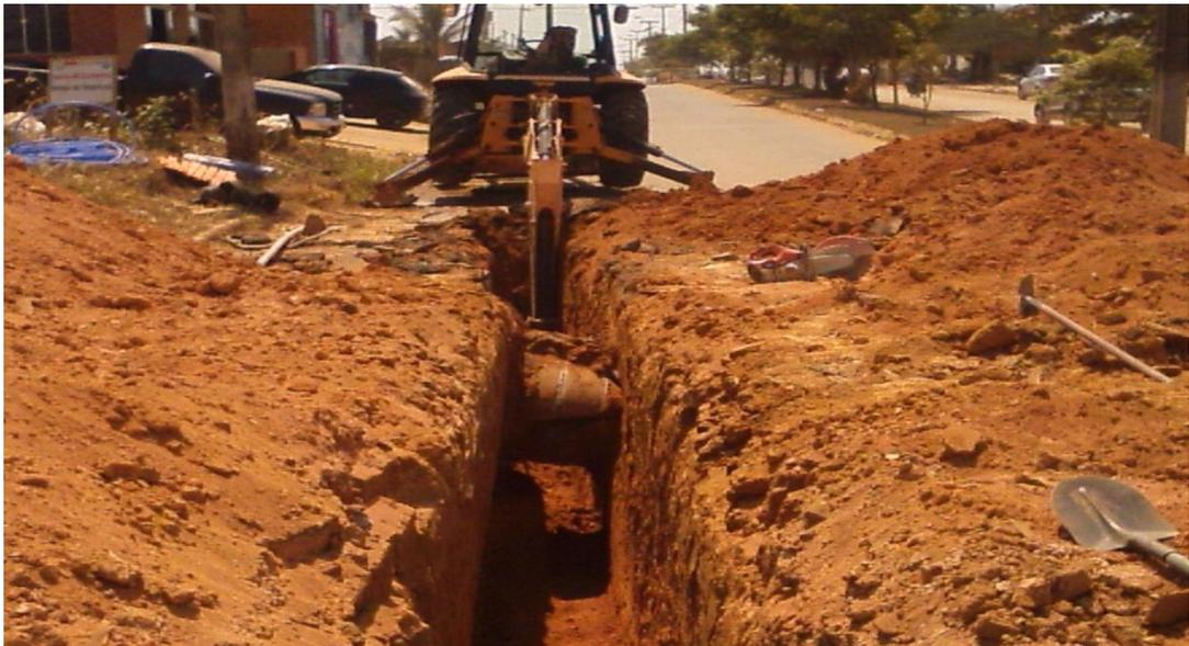
**5ª foto: assentamento de tubulações de 50mm de PVC, 200mm de FoFo e 300mm de FoFo**
