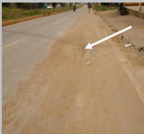
**Foto 02: ponto com recalque.**
