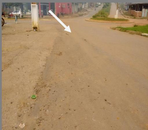
**Foto 04: ponto com recalque.**
